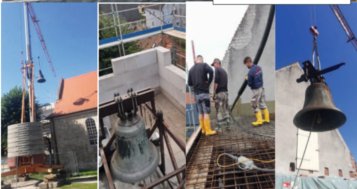
Wiederaufbau des Kirchturmes in Markröhlitz
